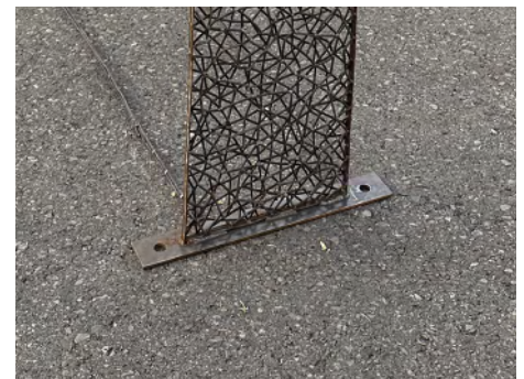
Befestigung mit Erdnägeln
